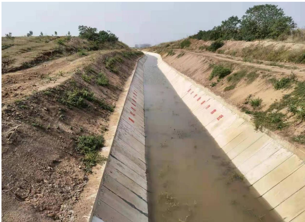
图 2-1 C30 钢筋混凝土预应力多孔板护砌效果
