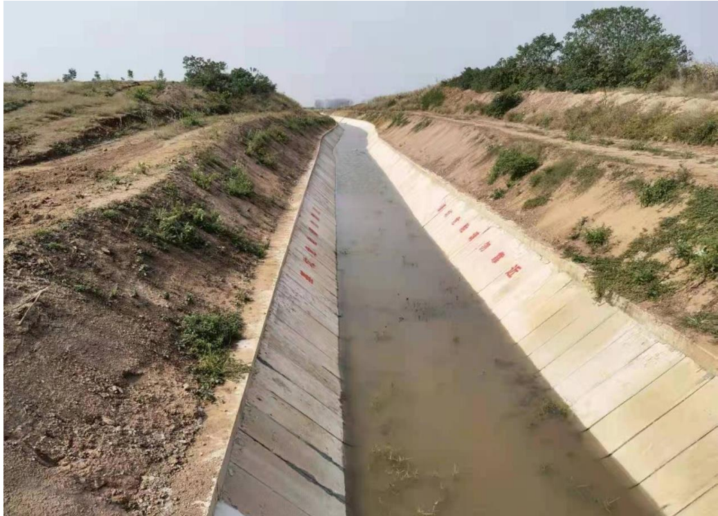
图 2-1 C30 钢筋混凝土预应力多孔板护砌效果
